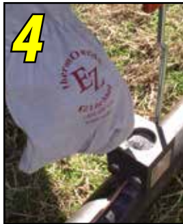
4 Pour weld metal into mold.
