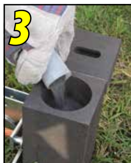
3 Pour powder into crucible.
